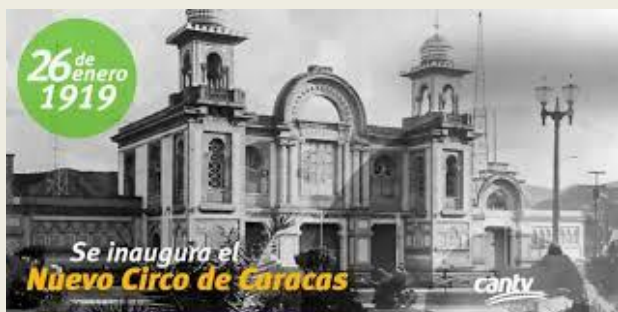
Fachada del Nuevo Circo el día de inauguración.
